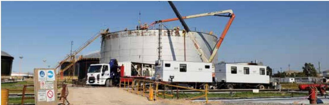
La unidad de Servicios Ambientales de AESA e YPF, diseñaron y activaron equipamiento de última generación tecnológica destinado al servicio de limpieza automática de grandes tanques de hidrocarburos y a la separación de lodos en un mismo proceso.
